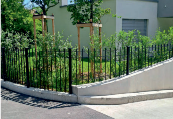
Modell "Modern Light", Vierkantstab 12 x 12 mm (Abstand 120 mm), Flacheisen 30 x 6 mm
