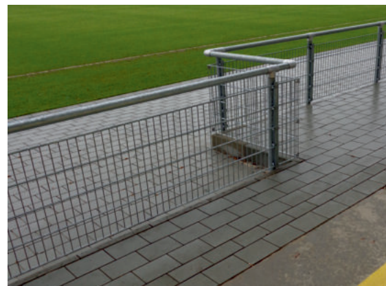
Barriersystem mit Doppelstabgitter Befestigung Pfosten-Typ FA
