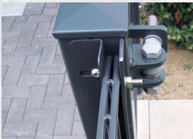
**Ausstattung:** Rohrrahmenschluss, verzinktes Einsteckschloss, PZ-vorgerichtet mit Zylinder, Aluminium-Drückergarnitur, verstellbare Torbänder; Schlossflügel mit flexibler Öffnungsrichtung durch drehbaren Toranschlag und umlegbare Schlossfalle, mit Zaunanschlussleisten für beide Torpfosten (liegen lose dabei und müssen bei Bedarf bauseits angeschraubt werden), bei zweiflügeligen Toren: Mittelverriegelung, 2 Stück Bodenhülsen (Feststellflügel), 1 seitlicher Hakenfeststeller (Gehflügel).
